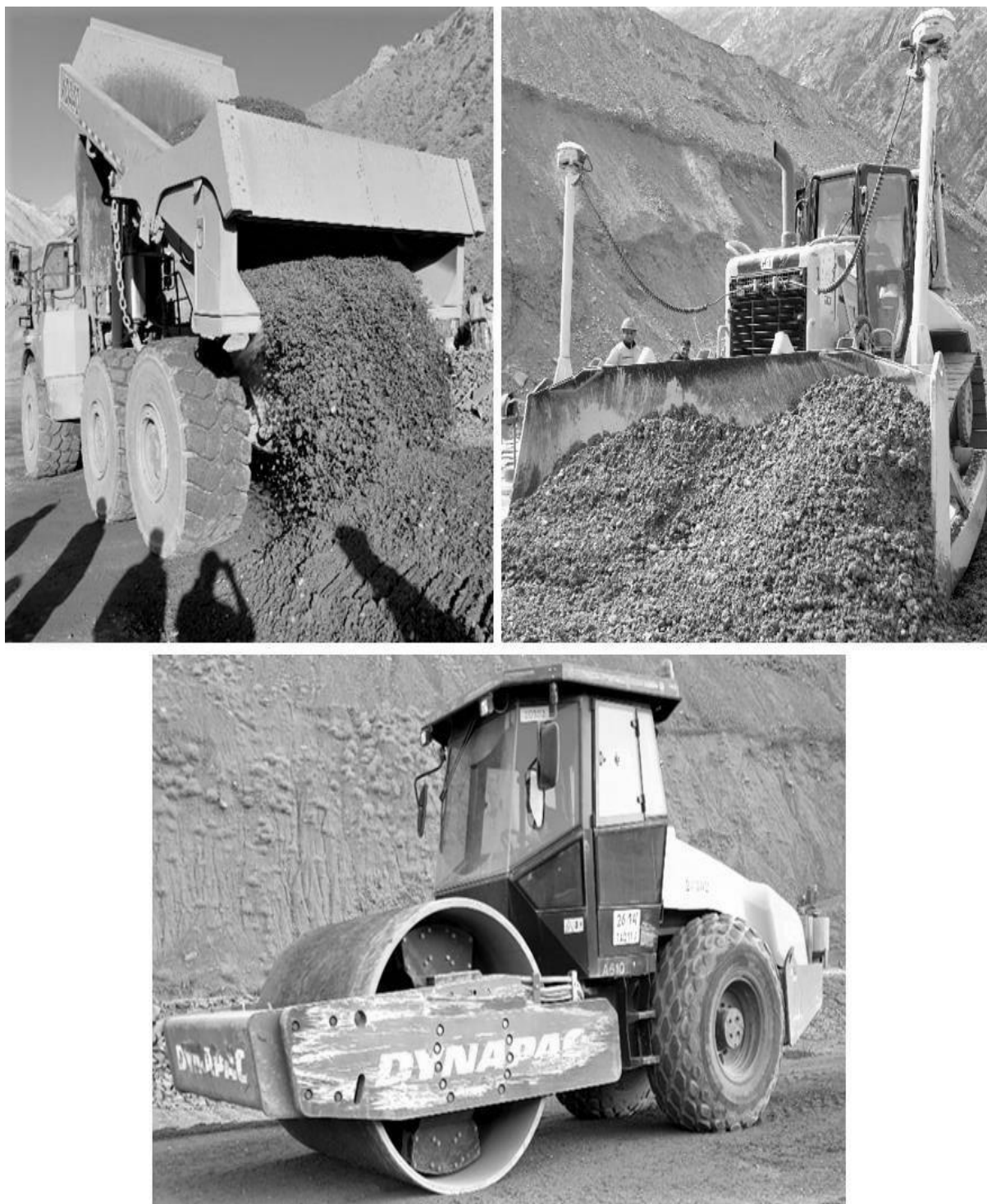
Расми 1. Рафти корҳои бетони шибакардашуда (УКБ) тавасути механизмҳо
